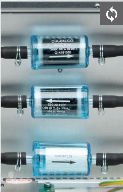
Gasaufbereitung mit Aktivkohle und PTFE -Filter
